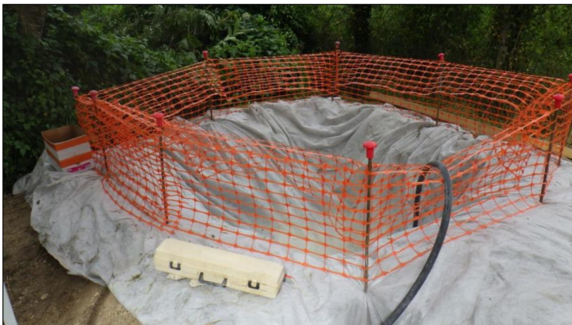
Figure 9 : Exemple d'un bassin de décantation provisoire pour les eaux d'exhaure de batardeaux
