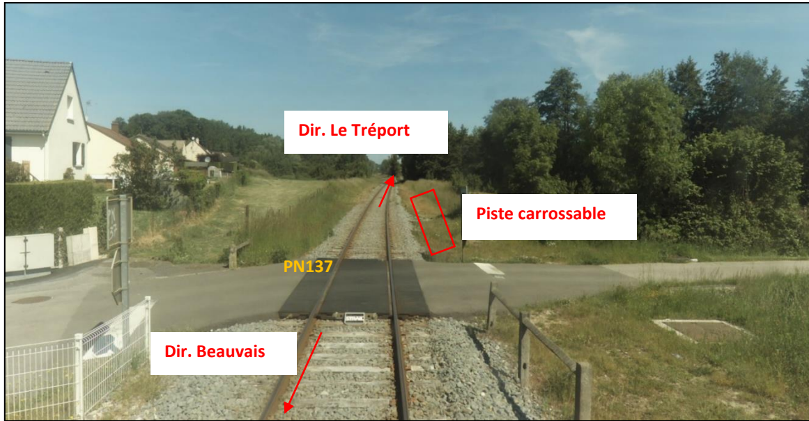
Figure 7 : Ligne 325 000 - Piste d'accès carrossable au PRA situé au PK 144+887 depuis le PN137 situé au PK 144+703
