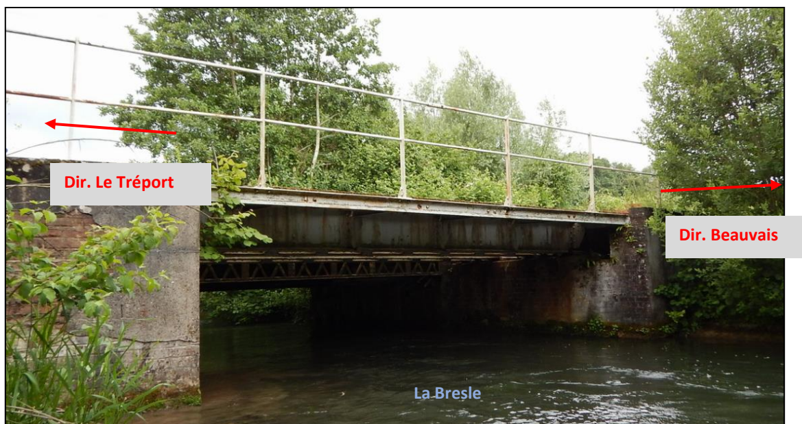
Figure 3 : Ligne 325 000 - Élévation gauche de l'ouvrage situé au PK 144+887
